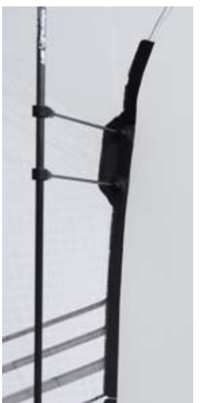
Stand-Offs mit verstärkter Endkante des Segels
